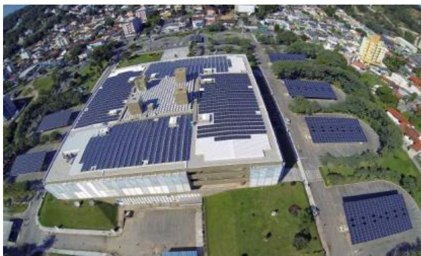
Figura 2.10: Edifício Sede da Eletrosul em Florianópolis-SC, com geradores solares fotovoltaicos integrados na cobertura do prédio e nos estacionamentos, somando 1 MWp de potência.
