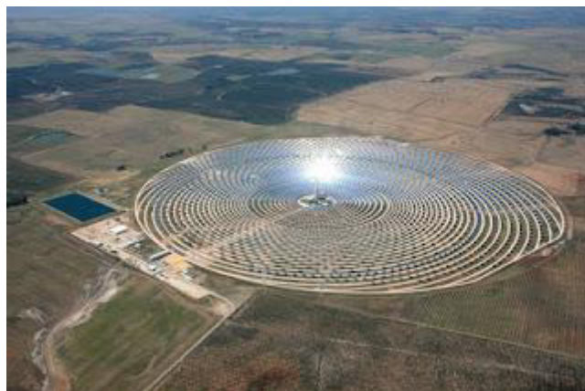
Figura 2.13: Usina Gemasolar na Espanha
